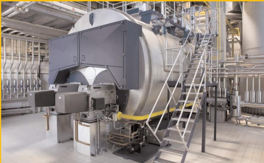
Горелки Weishaupt типоряда WK разработаны специально для промышленного применения. Благодаря модульной конструкции эти горелки могут быть адаптированы для множества специальных задач. Большой диапазон мощности допускает широкий спектр применения.
